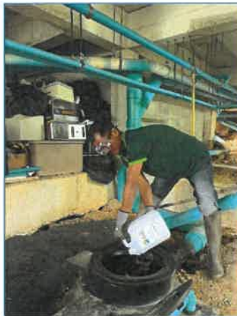
ภาพถ่ายการเติมหัวเชื้อชีวภาพ (EM) ในถังบำบัดน้ำเสีย
