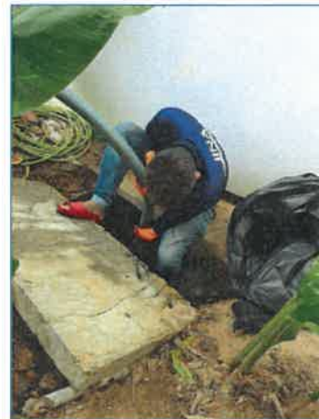
ภาพถ่ายที่ 2.2-19 การสูบละกอนในถังเกรอะ
