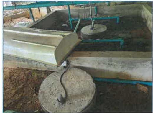
ระบบบำบัดน้ำเสียและถังพักน้ำทิ้งก่อนเติม EM ปรับสภาพ และนำไปรดน้ำต้นไม้
