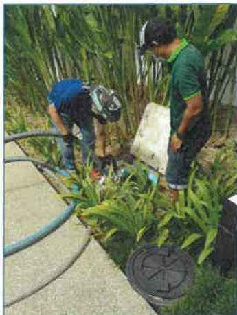
ภาพถ่ายที่ 2.2-19 การสูบละกอนในถังเกรอะ
